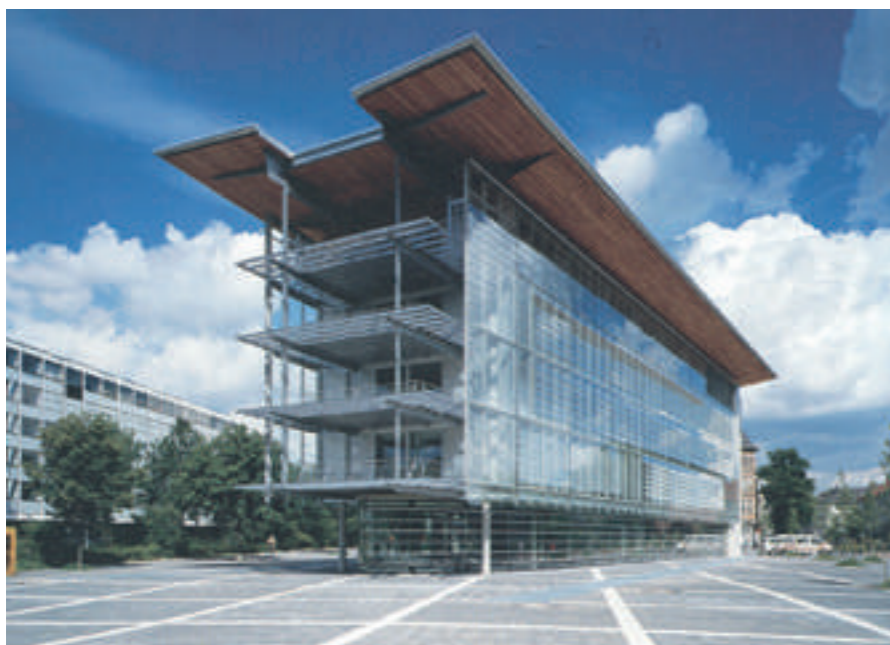
Edificio Haus am MIR. Hansen Pettersen
